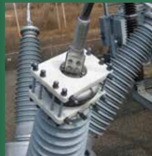
En haut à gauche : Une bride qui fuit dans la vallée de le GIS de la société Southern California Edison. En haut à droite : le boîtier sur mesure installé par Colt.
