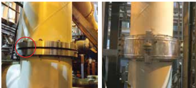
En haut à gauche : Une bride qui fuit dans la vallée de le GIS de la société Southern California Edison. En haut à droite : le boîtier sur mesure installé par Colt.
